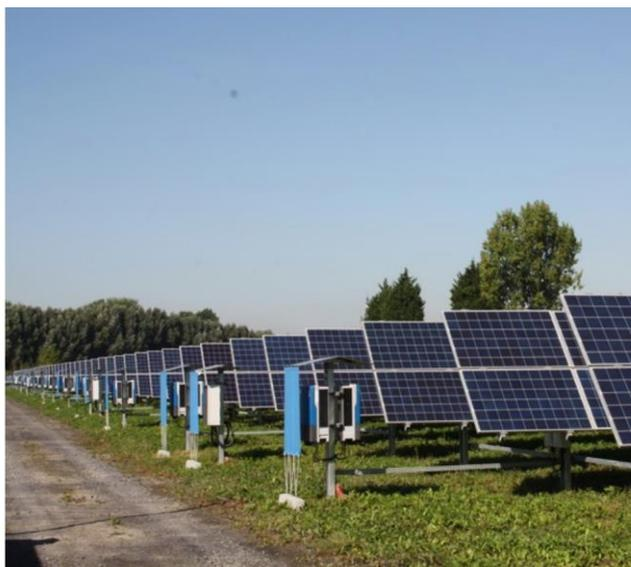
La CENTRALE SOLAIRE de MERVILLE est la plus grande construite dans le Nord Pas de Calais par la société ALTUS ENERGY dont le siège est à SOPHIA ANTIPOLIS. De puissance relativement modeste de 1200 KW, elle alimente l'équivalent de 200 foyers. Sur 2 hectares sont installés 1200 panneaux solaires mobiles pour suivre la course du soleil.
